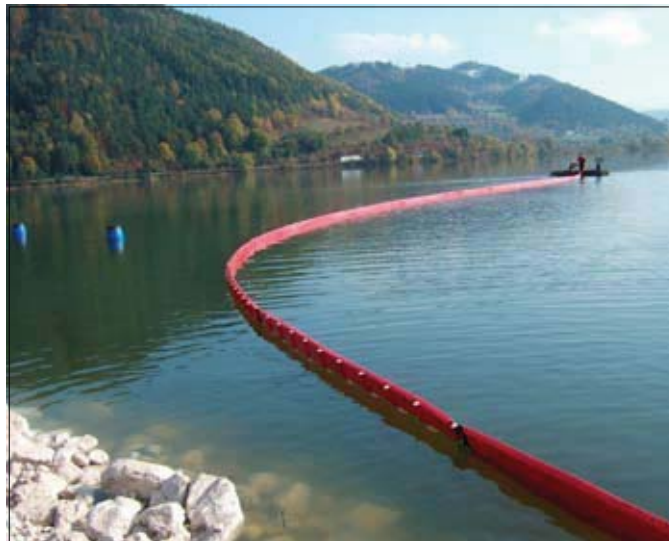
В течение года защита входа небольшой гидроэлектростанции. Боновое заграждение REO758 предотвратило загрязнение на воде.
