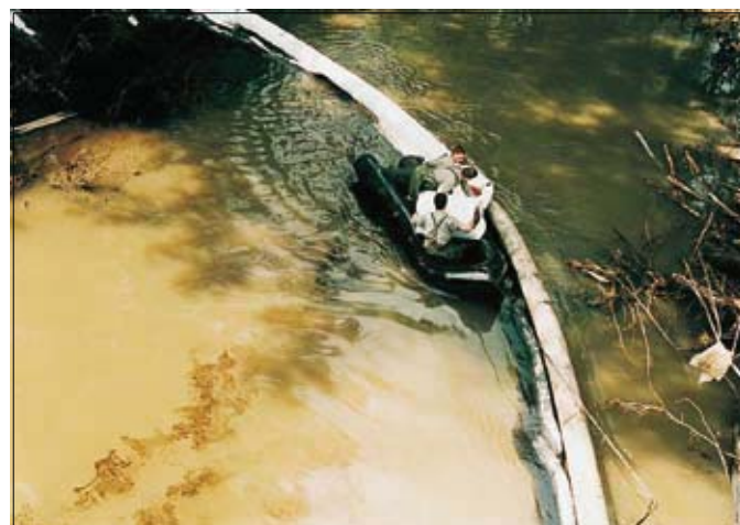
Эффективный способ задержать разливающуюся нефть при помощи барьера и абсорбирующего коврика.
