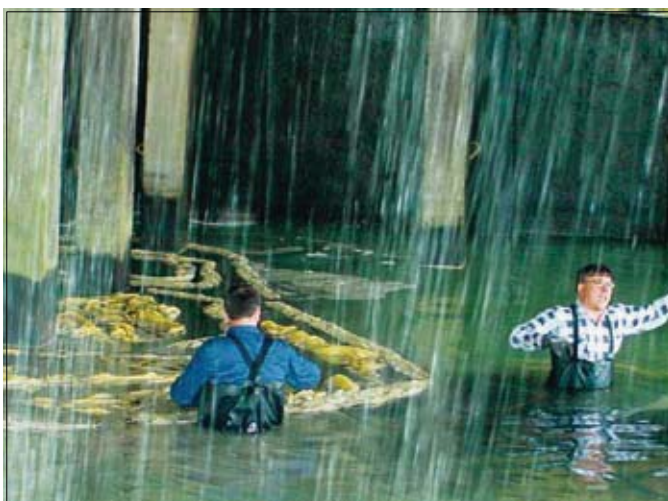
Составные волокна REO Fb, использовались для удаления гидравлического масла, вылившейся из резервуара на электростанции
