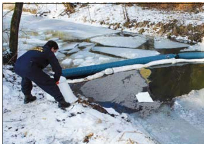
Очищение загрязненной воды при помощи листов абсорбирующего коврика
